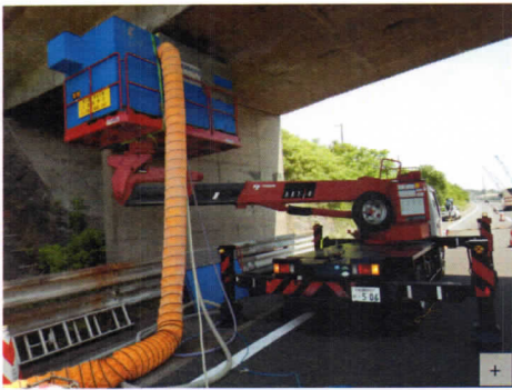
防塵ボックスを用いて壁高欄外面や橋脚梁部をはつっている状況
