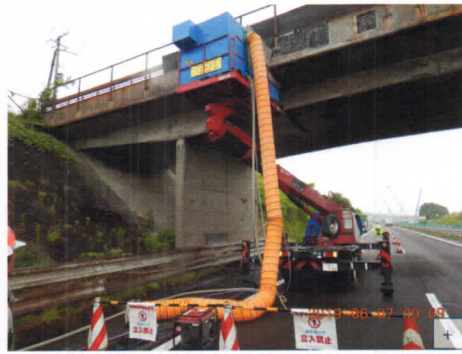
防塵ボックスを用いて壁高欄外面や橋脚梁部をはつっている状況
