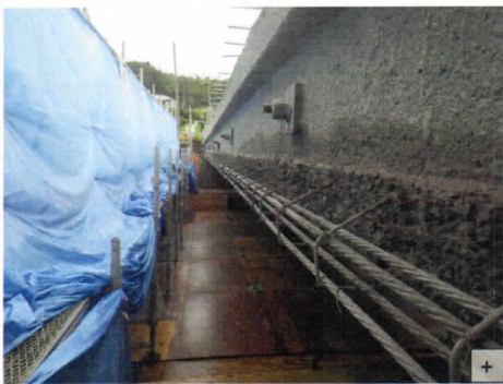
PC桁のはつり状況
