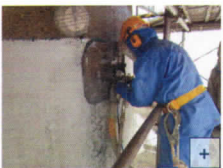
WJを用いた炭素繊維シートの除去(左、中左)/カルポートボックス下面のはつり状況
