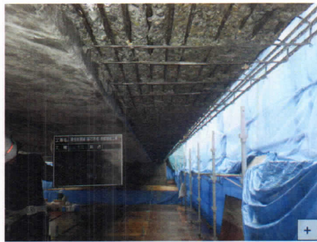
PC桁のはつり状況
