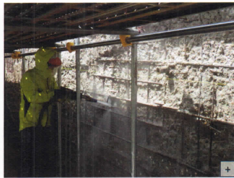
30Mpa、50MpaマシンによるWJサンドブラスト鉄筋錆落とし
