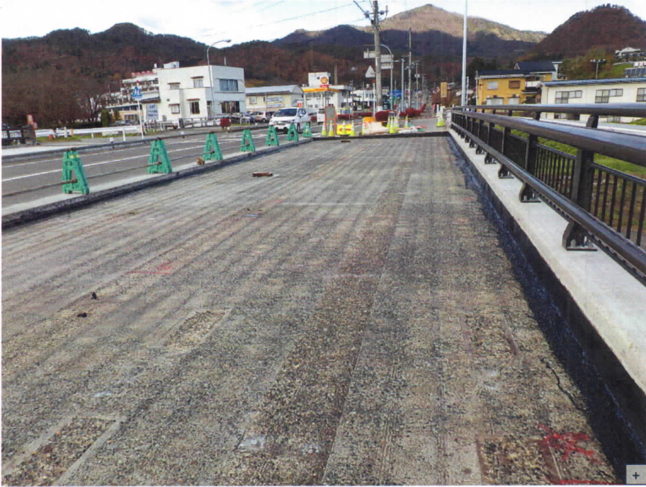
床版上面のWJ施工状況
