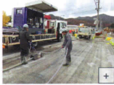
防塵ボックスを用いて壁高欄外面や橋脚梁部をはつっている状況
