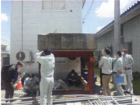
撤去床版を用いた床版診断など様々な取組みも行っている/『エンジニアリングジャッジ』も学ぶ
