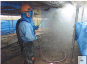
WJを用いた炭素繊維シートの除去(左、中左)/カルポートボックス下面のはつり状況
