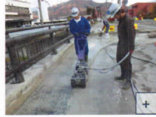
防塵ボックスを用いて壁高欄外面や橋脚梁部をはつっている状況
