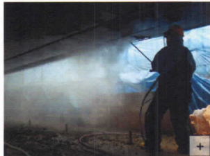
WJを用いた炭素繊維シートの除去(左、中左)/カルポートボックス下面のはつり状況
