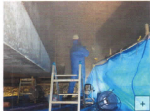
WJを用いた炭素繊維シートの除去(左、中左)/カルポートボックス下面のはつり状況
