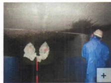
WJを用いた炭素繊維シートの除去(左、中左)/カルポートボックス下面のはつり状況
