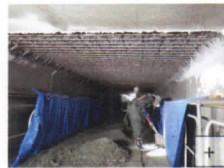
WJを用いた炭素繊維シートの除去(左、中左)/カルポートボックス下面のはつり状況
